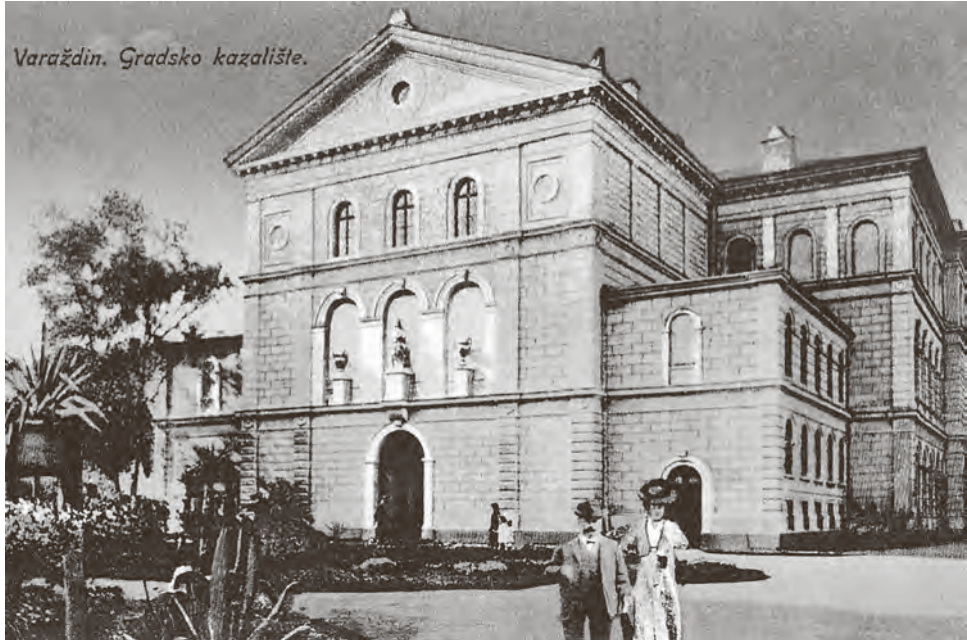
Pogled na kazalište od strane šetališta (istočno pročelje), razglednica, oko 1920., HR-DAVŽ.
