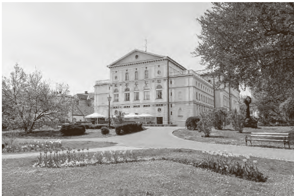
Južno pročelje s nadogradnjama, 2024. Foto: Andrej Švoger.
